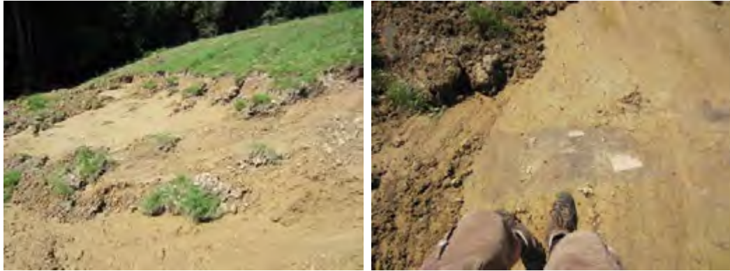
Figur 42: Anrissbereich einer Hangmure mit freigelegtem Fels. Wenige Dezimeter mächtiger Ausbruchsbereich einer Hangmure (links) und deren Gleitfläche auf Mergel/Sandstein (rechts) (Ereignis Hm_3, vgl. Beilage 31 ). Aufnahmen vom 12.07.2011.
