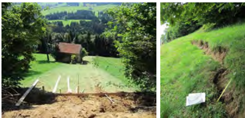
Figur 41: Ausbruchs- und Transitbereich einer Hangmure aus einer steilen Böschung im Eisigeli (Ereignis Hm_1, vgl. Beilage 31 ). Der Holzschuppen wurde beschädigt. Aufnahmen vom 12.07.2011.
