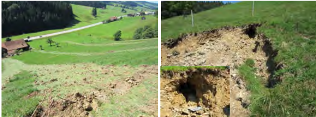
Figur 43: Auswirkungen der hohen Niederschlagsintensität. Der intensive Oberflächenabfluss zeigte sich in der grossen Reichweite des stark verflüssigten, mobilisierten Lockermaterials (Bild links). Limitierend auf die Reichweite wirkte neben dem bewaldeten Teil der Transitstrecke auch die infolge von Trittbremen erhöhte Bodenreibung (links). Am obersten Anrisspunkt eines Ereignisses (Hm_2, vgl. Beilage 31 ) wurde ein Hangwasseraustritt beobachtet (rechts). Am gleichen Hang weiter unten wurde innere Erosion durch Hangwasser beobachtet, welche lokal Löcher im Boden verursachte. Aufnahmen vom 12.07.2011.
