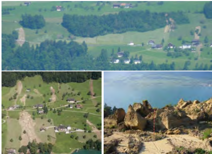
Figur 23: Fotos von Ereignissen Ennetbürgen. Oben Mai 2013, unten August 2005, links Übersicht, rechts abgehobene Felschicht.
